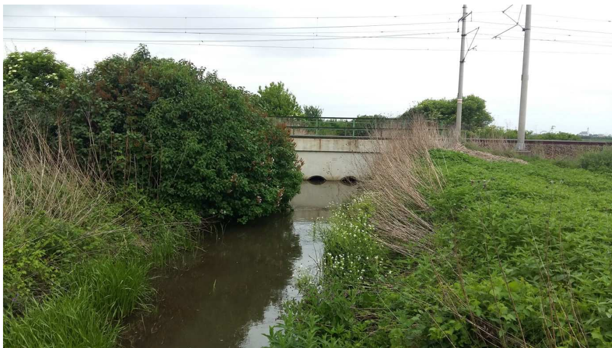
Obrázek 4 – Železniční most s propustkem - 2x DN 1200 v ř. km 10,485
