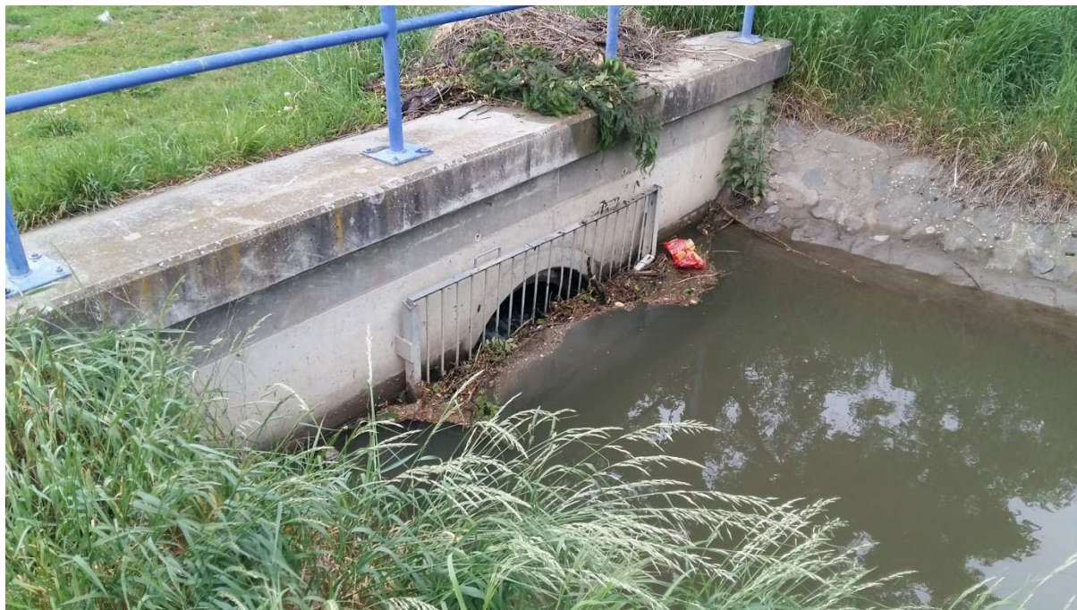
Obrázek 11 - Vtokový objekt zatrubnění – DN 1000 s česlicemi v ř. km 11,161
