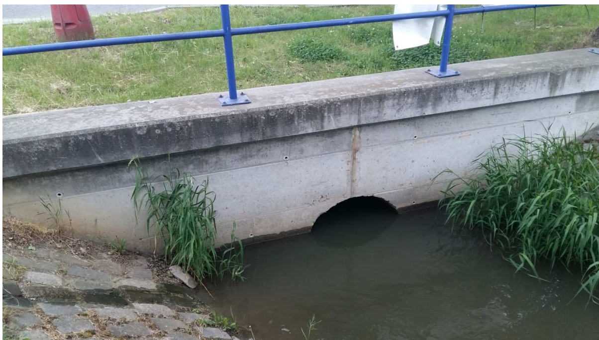
Obrázek 10 – Výtokový objekt zatrubnění – DN 1000 v ř. km 11,123
