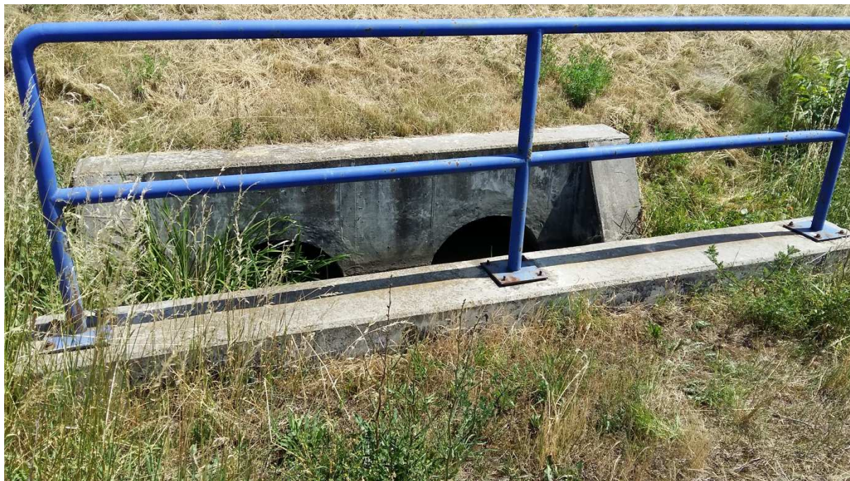
Obrázek 5 – Výtokový objekt propustků – 2x DN 1000 v ř. km 11,519
